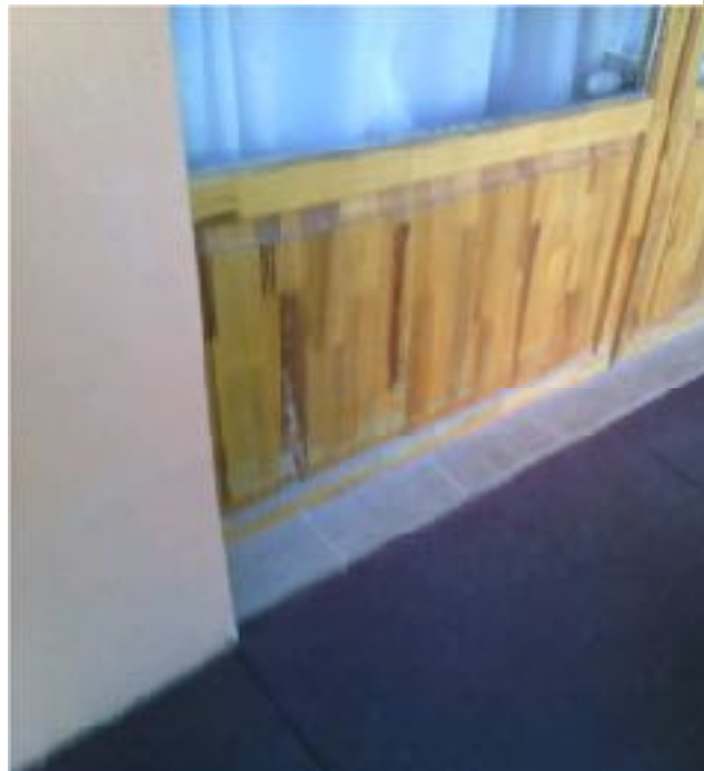
17.) Földszinti, déli oldali foglalkoztató szoba, szakipari fal alatt jelentős a padlón mérhető hiszivárgás
